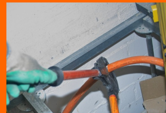
Kabelrückbau Hochhaus Trianon Frankfurt (M)
