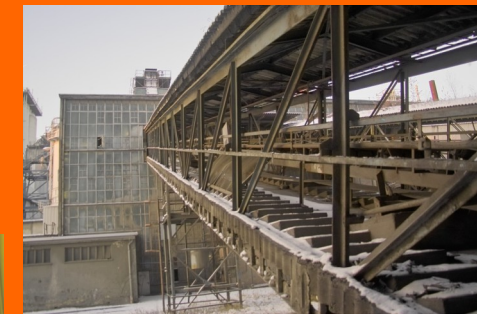
Cemex Schrägbandbrücke
