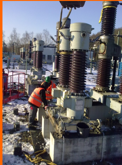
Ölschalerrückbau UJW Rudersdorf
